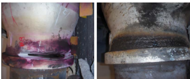
(a)返修前(已清除缺陷) (b)返修后焊缝
